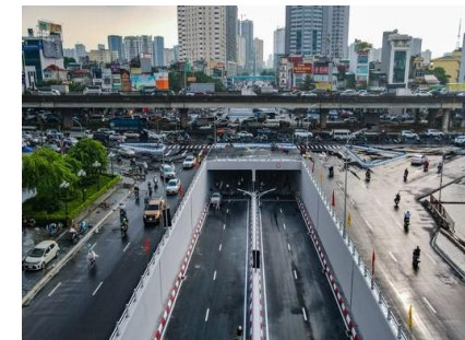
Le Van Luong Tunnel
